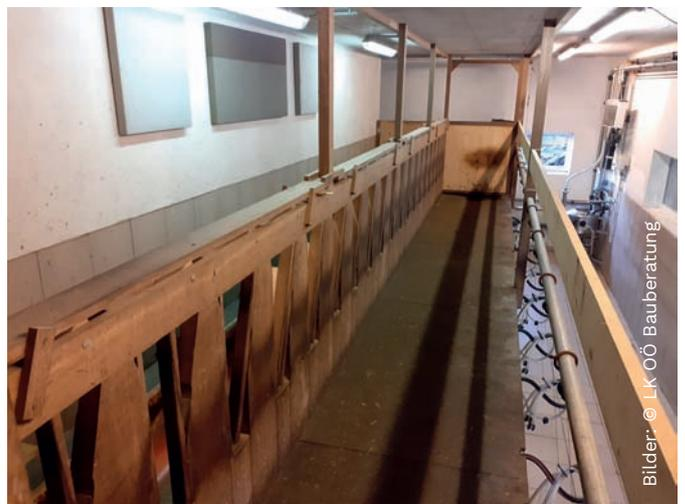
Foto 25 und 26 | erhöhter Melkstand in Holzbauweise
