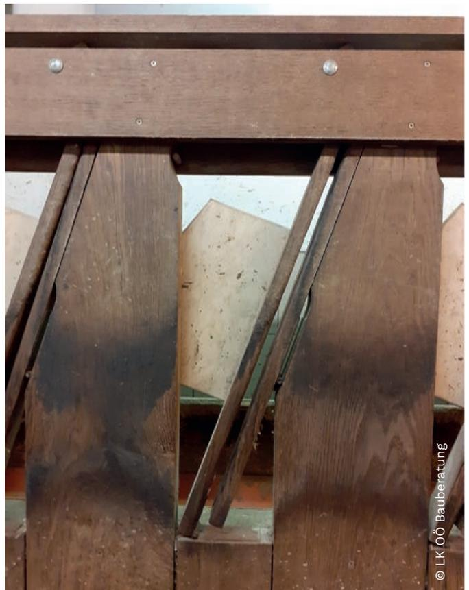
Foto 27 | Selbstfangfressgitter am Melkplatz in Eigenbauweise
